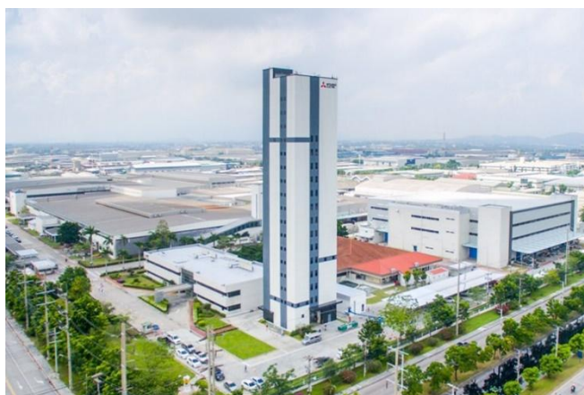
Nova torre de teste
