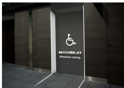
Orientação projetada na porta do elevador
