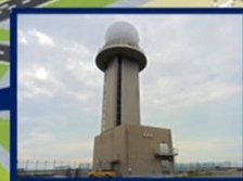
Radar meteorológico Doppler de aeroporto Para detetar vento lateral em condições com precipitação
