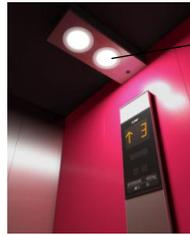
Os LED opcionais nos tetos reduzem o consumo de energia para a iluminação em 60% em comparação com a iluminação fluorescente convencional e têm uma duração 12 vezes superior
